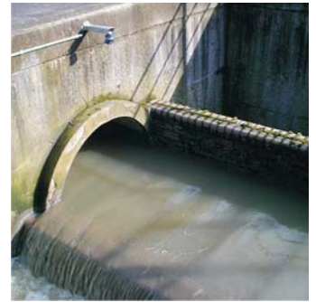
수위 측정 현장
