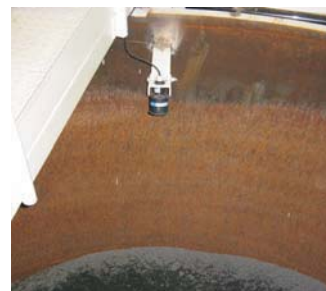
탱크 내부 수위 측정 현장
