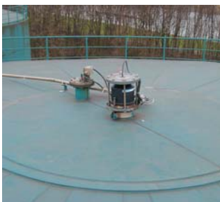
탱크 내부 수위 측정 현장
