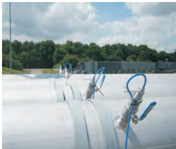
삽입형 센서 설치 적용 현장
