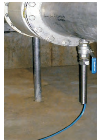
삽입형 센서 설치 적용 현장
