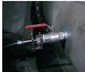
삽입형 센서 설치 적용 현장
