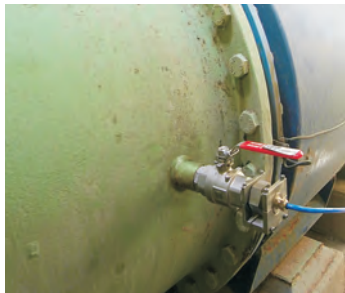
삽입형 센서 설치 적용 현장
