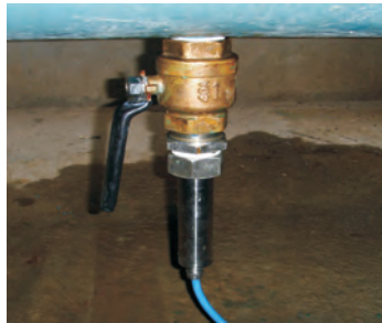
삽입형 센서 설치 적용 현장
