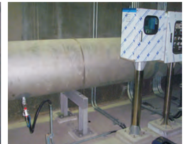
삽입형 센서 설치 적용 현장
