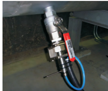
삽입형 센서 설치 적용 현장
