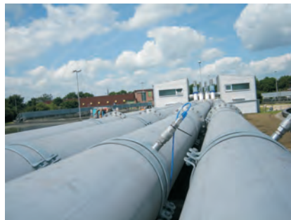
삽입형 센서 설치 적용 현장
