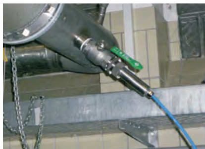
삽입형 센서 설치 적용 현장
