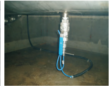
삽입형 센서 설치 적용 현장
